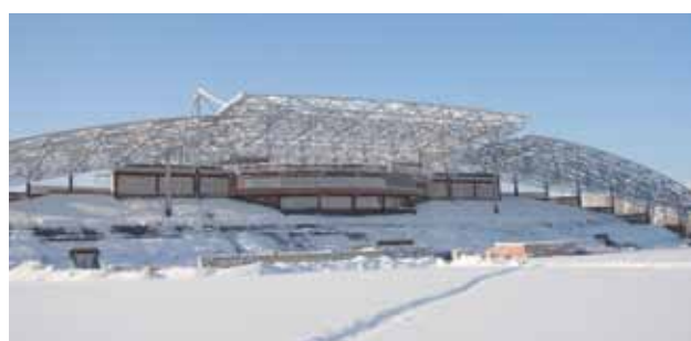
Стадион для биатлона в Ханты-Мансийске – монтаж систем водоснабжения и отопления
