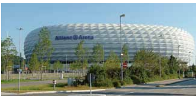
Allianz Arena в Мюнхене – монтаж системы водоснабжения
