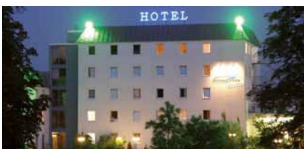
Parkhotel в Нойбранденбурге – нагрев питьевой воды и поддержка отопления с использованием солнечной энергии
