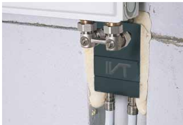
Подключение отопительных приборов из стены.
