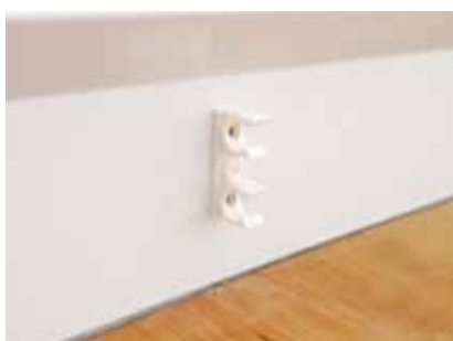
Монтаж крепления регистра
