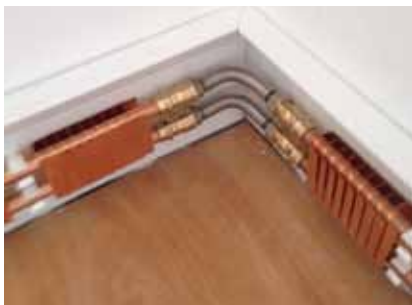
Монтаж углов с помощью поворотного компенсатора
