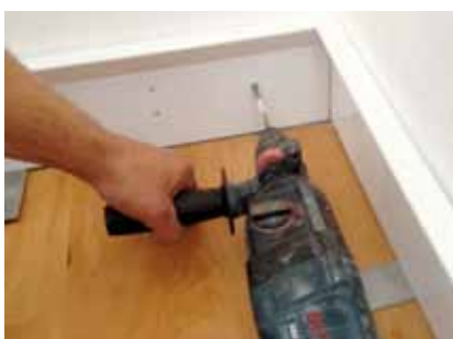
Монтаж базового профиля
